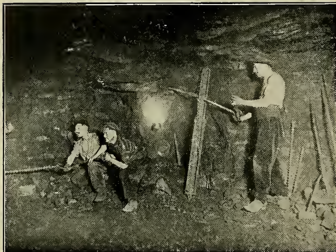
Mine de Moutiers. — Perforatrice à main.
